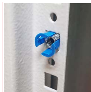
Exemplu de montaj piuliță captivă
